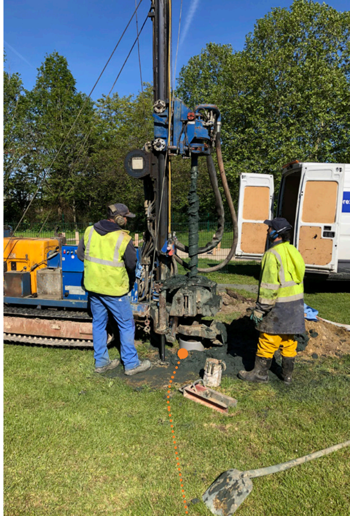
Een onderaannemer voert een grondboring uit.
