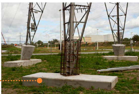
..... Versterkte fundering van een bestaande mast.
