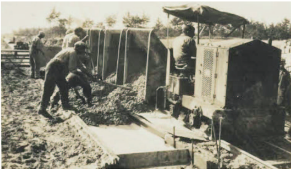
Foto12: E40 in aanbouw 1937, Hugo Vrielynck, Stadsarchief Brugge/Verz. J. A. Rau: aanleg van de autosnelweg te Loppem 1937
