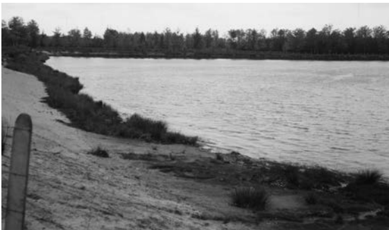
Aanleg van de autostrade Brussel-Oostende te Loppem: 1. De uitvoering van de werken (BB1) – 2. Brug over de oude spoorwegbedding (GAZ) – 3. De latere Lac van Loppem (BB2)
