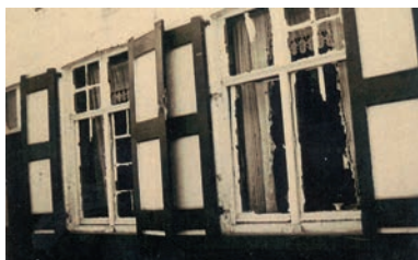
Beschadiging aan de woning Osselaere (Collectie Guy Osselaere)
