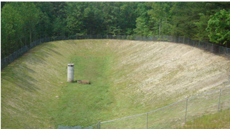
Figuur 48 Voorbeeld van een wadi (met overloopvoorziening)
