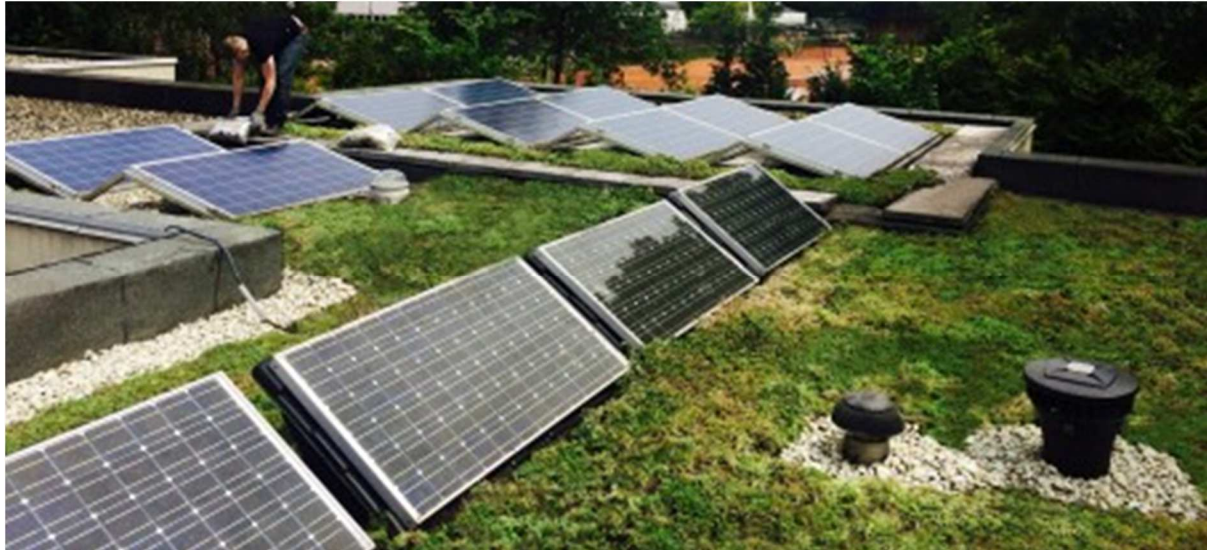
Figuur 63 Voorbeeld van een groendak in combinatie met zonnepanelen
