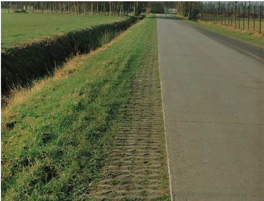
Figuur 46 Grasbetontegels aangelegd in de wegberm (naast de wegverharding)
