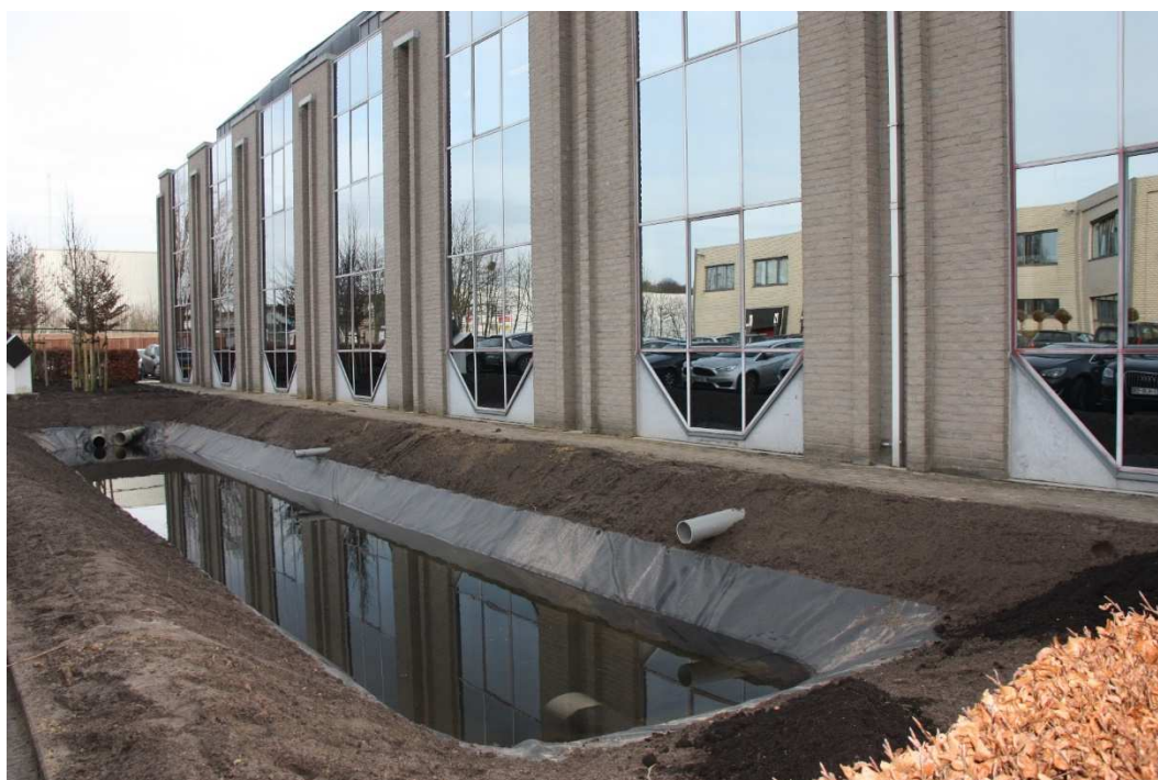
Figuur 44 Voorbeeld van hergebruik van regenwater, in het hoofdkantoor van Aquafin
