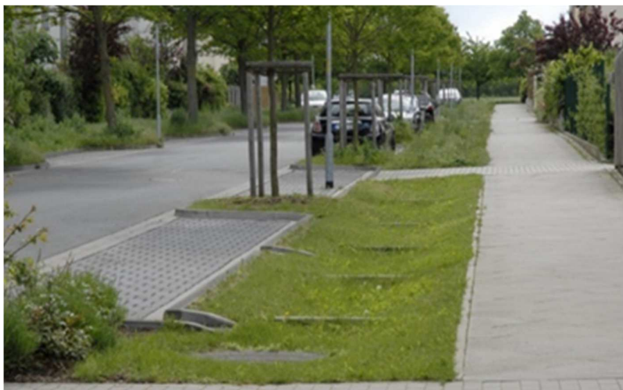
Figuur 57 Voorbeeld van een infiltrerende berm (met tussendrempels) langs de weg
